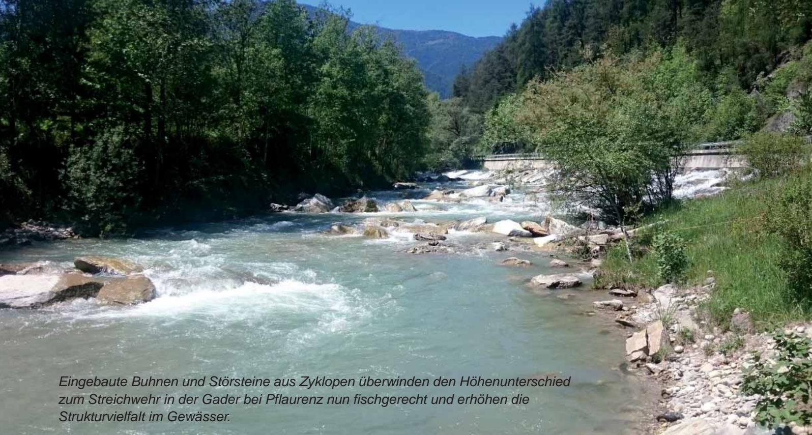
*Eingebaute Bühnen und Störsteine aus Zyklopen überwinden den Höhenunterschied zum Streichwehr in der Gader bei Pflaurenz nun fischgerecht und erhöhen die Strukturvielfalt im Gewässer.*
