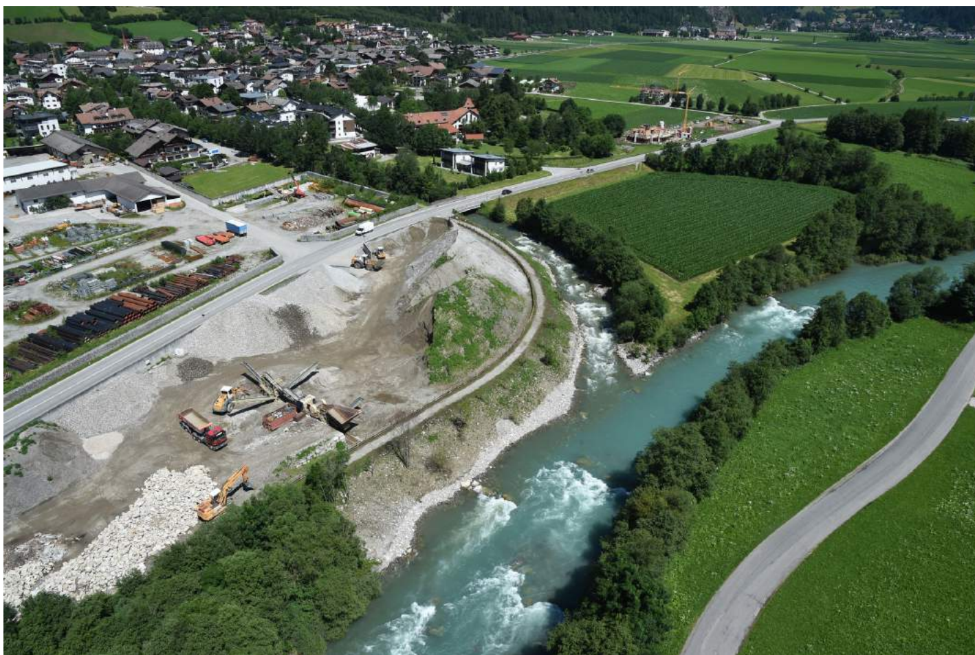
Vogelperspektive auf den neu gestalteten Mündungsbereich des Mühlwalderbaches. Der Mündungsbereich wurde auf die doppelte Breite aufgeweitet, die aufgelöste Rampe ist selbst für Fische mit schwacher Schwimmleistung überwindbar.
