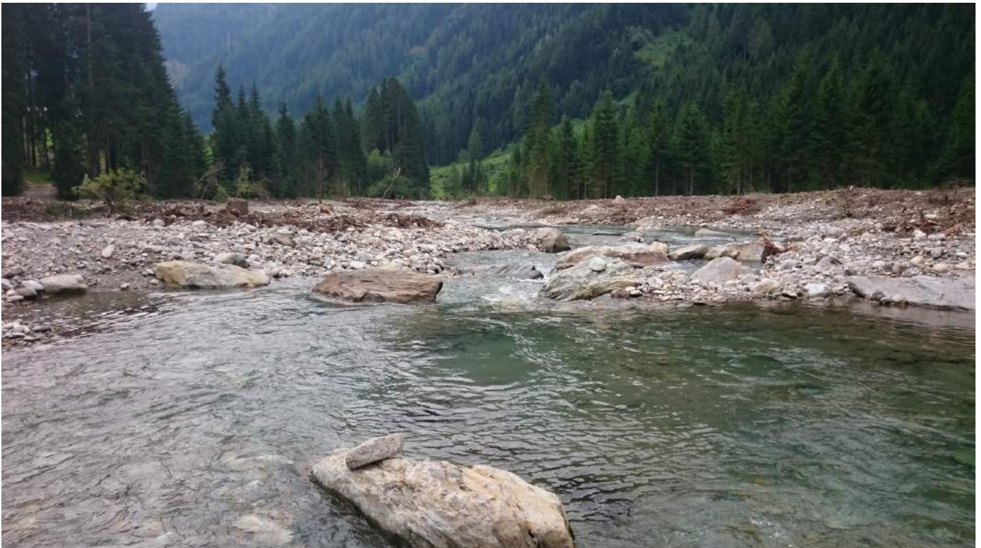
Revitalisierter Mühlwalderbach bei Unterlappach mit reichlich strukturiertem Niederwasserbett kurz nach Abschluss der Bauarbeit (Juli 2016). Im Uferbereich kann sich wieder natürlicher Auwald entwickeln.
